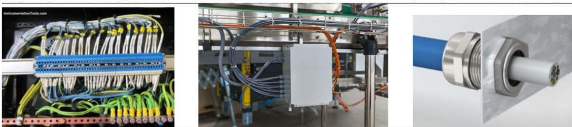
123. Nel caso delle cassette di giunzione/*cabinet*, se non vi sono problemi di limitazione di spazi nelle strutture in cui sono installati, sono più utilizzati i pressacavi rispetto ai sistemi di attraversamento multi-cavo di tipo modulare, perché sono meno costosi<sup>173</sup>.
